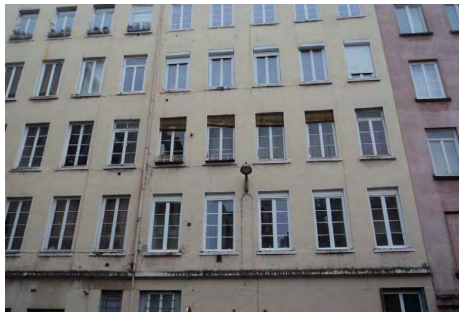
Equipements de production de chaleur et conséquences visuelles en façade. Photographies : ThermiFluides.
