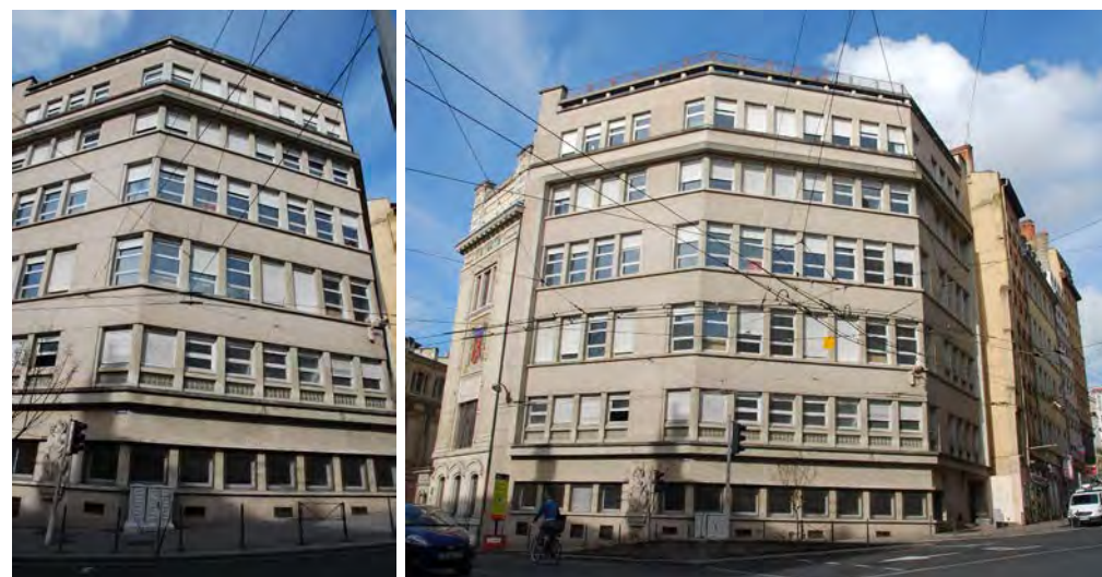
L'extension de l'école de la Martinière date de la fin des années 1950. L'édifice, de qualité, est représentatif d'une période souvent dénigrée car méconnue.
