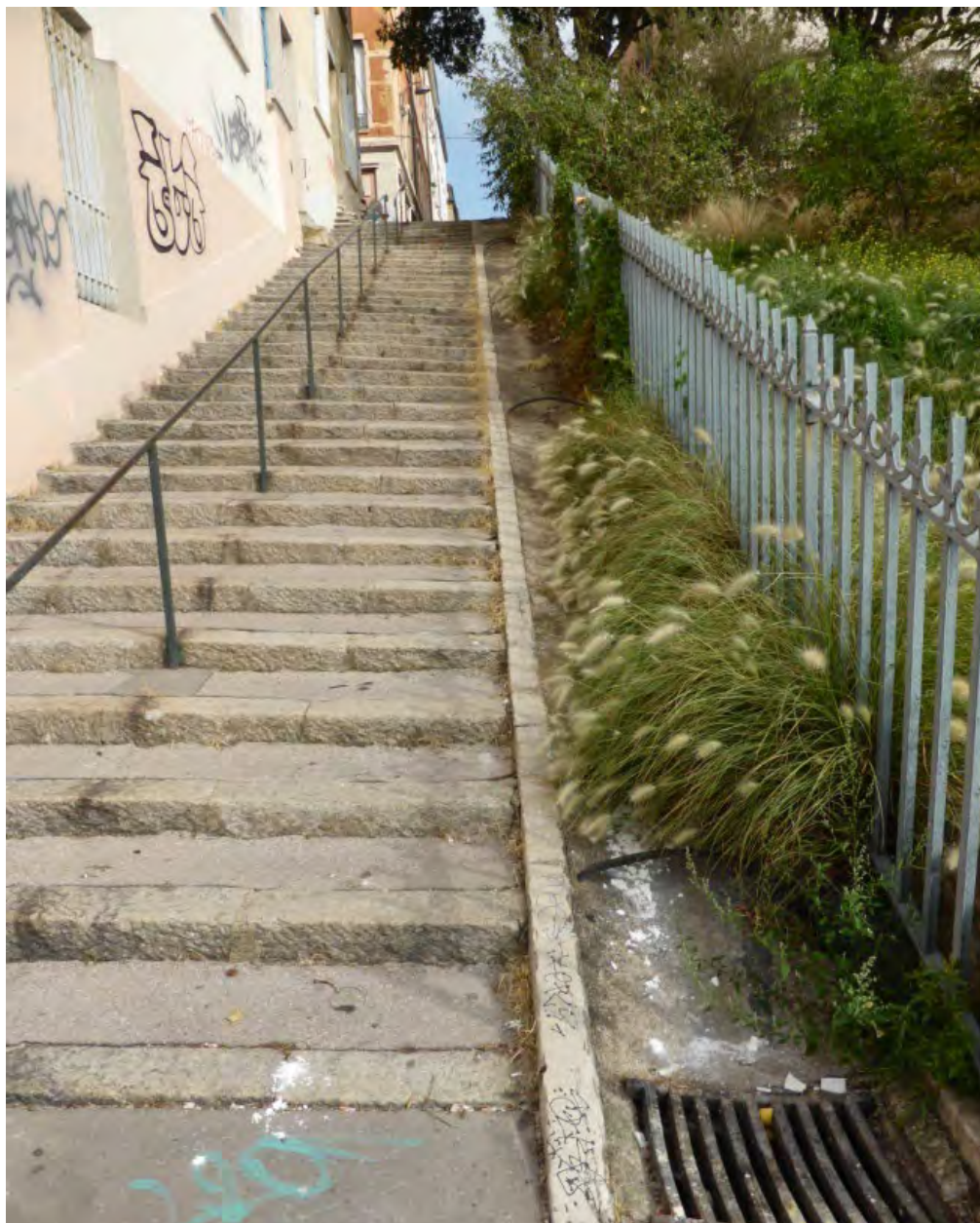
Escalier rue de Crimée. Photographie : Soberco Environnement
