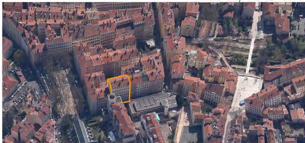
Vue depuis le Nord
