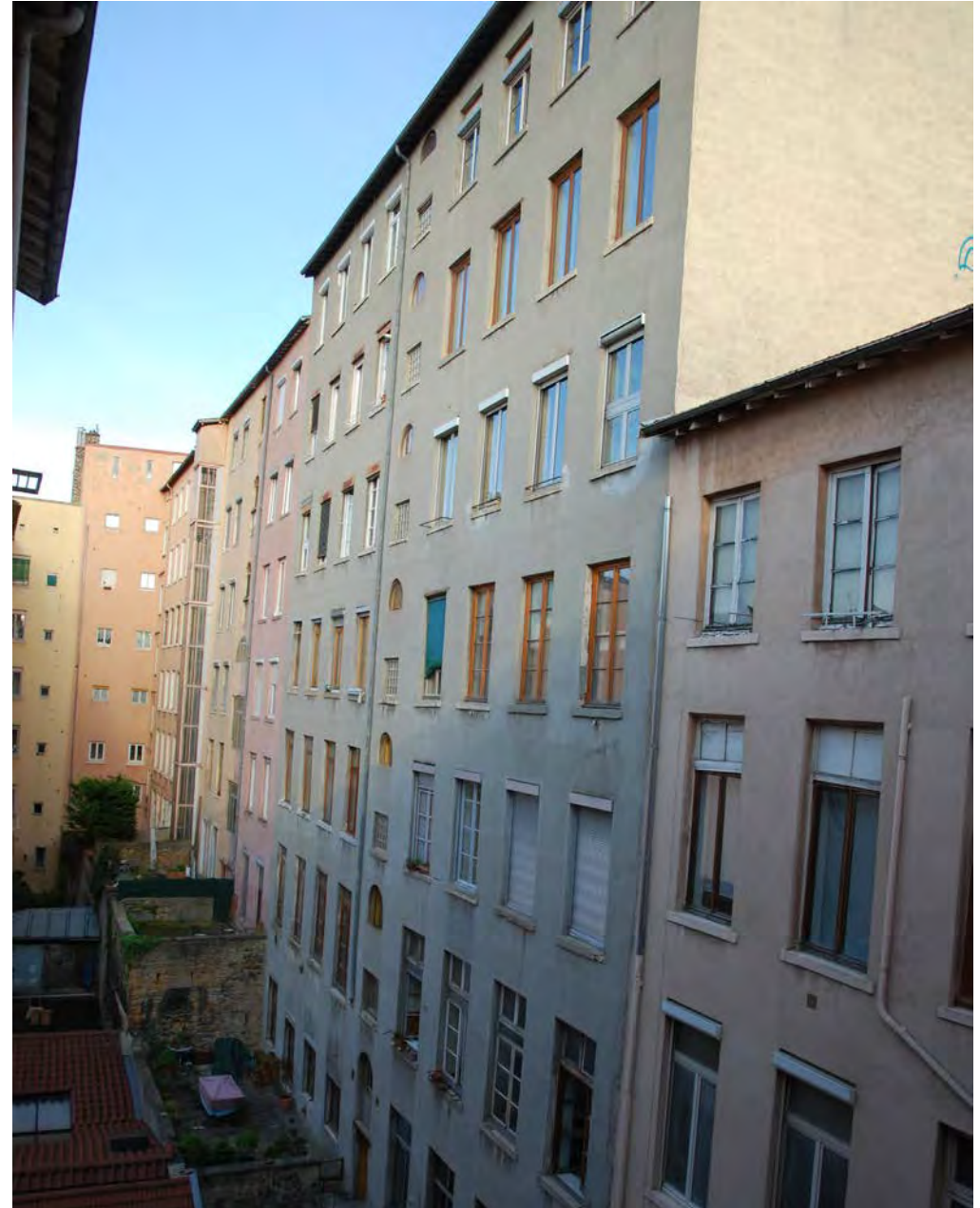
Façade arrière de l'immeuble étudié.
