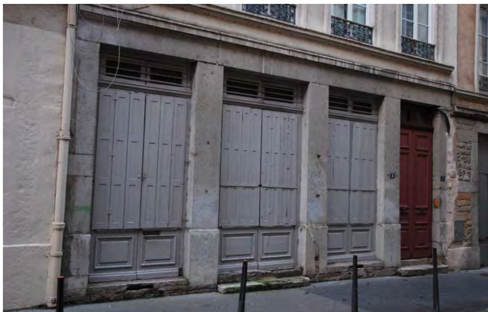
Les pierres à moellons et les pierres de taille - ici, une pierre de Villebois - n'ont pas le même aspect ni le même rendu. Chaque type de pierre a un usage spécifique.
