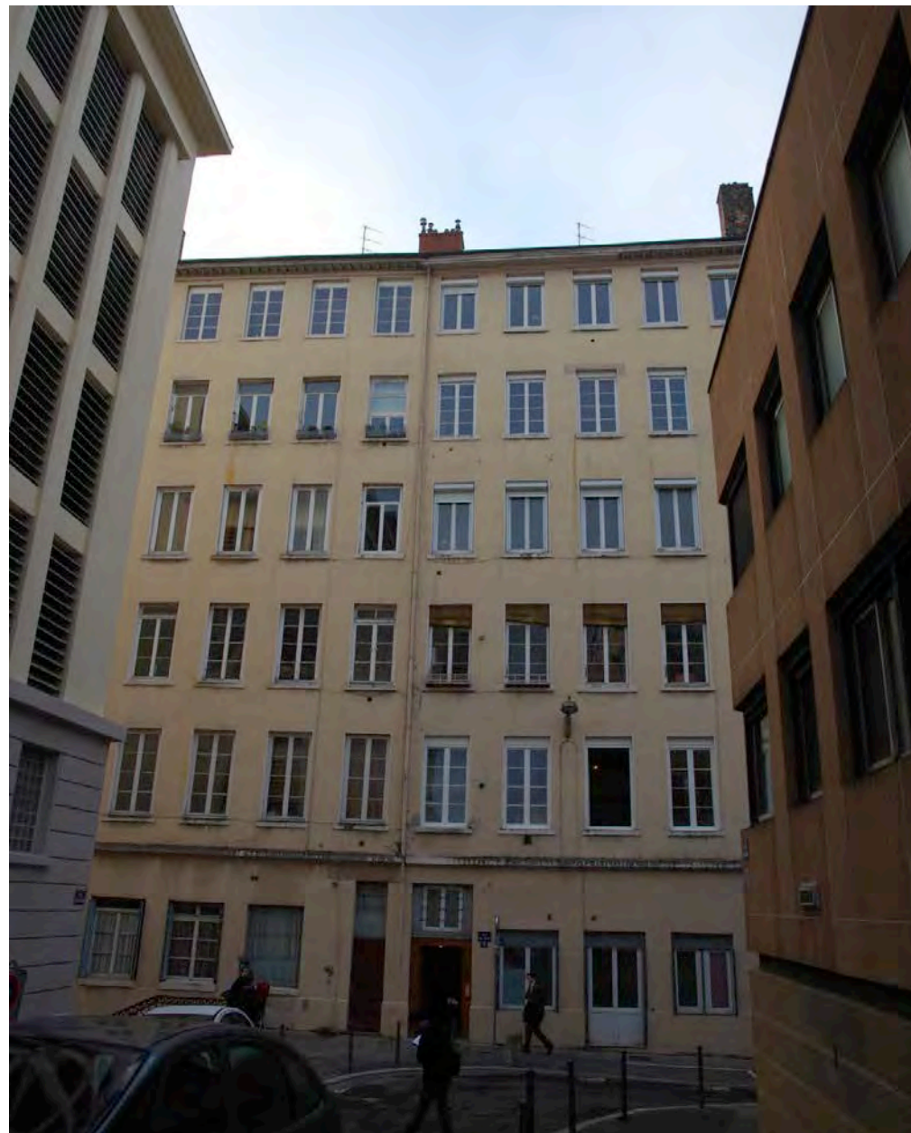
Le bruit mesuré sur les Pentes de la Croix-Rousse. Les quais, notamment ceux de Rhône, sont très bruyants pour les riverains. C'est également un secteur accidentogène.
