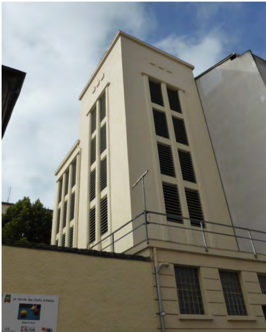
Tour d'aération du tunnel de la Croix-Rousse. (ci-dessus) Photographie Archipat
