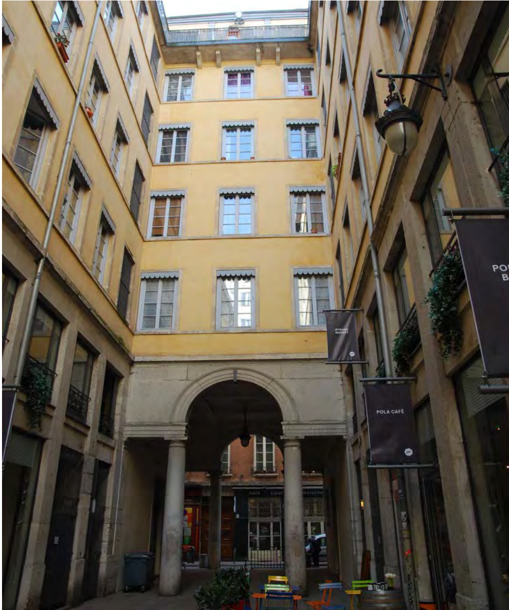
Le passage Thiffait, construit vers 1820, est l'un des emblèmes du renouveau du quartier. Photographie Archipat.
