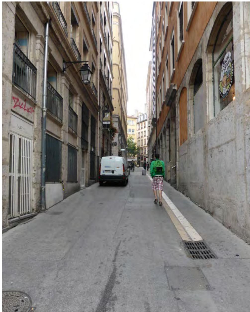
Réseau de collecte des eaux de surface le long des Pentes. Photographie : Soberco Environnement.
