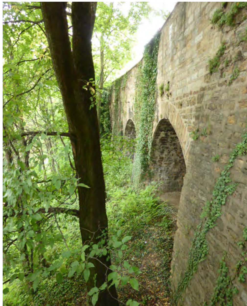
Ces murs de soutènement et leurs talus participent à la continuité de la trame verte. Photographies Soberco Environnement.
