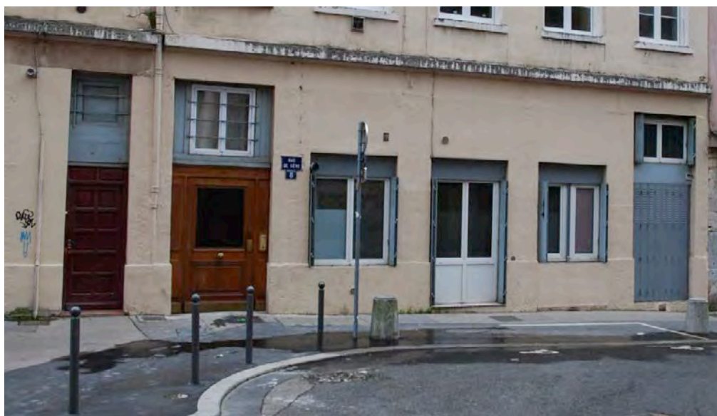
Diverses vues du rez-de-chaussée ou autres parties de l'immeuble. Les menuiseries ne sont pour la plupart plus conformes.
