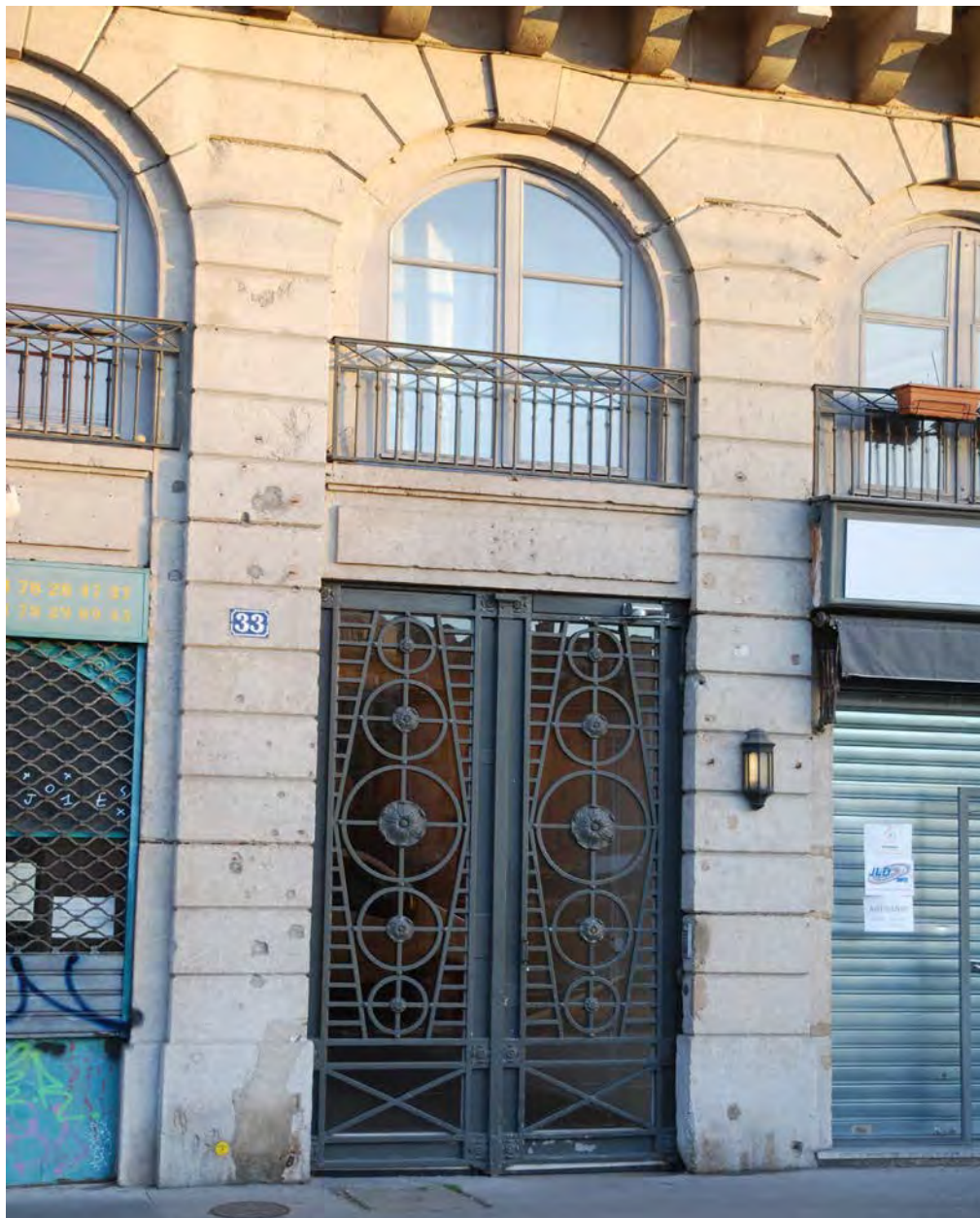
Les soubassements en pierre de Villebois sont omniprésents dans les constructions du XIX e siècle. Photographie Archipat.
